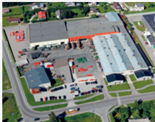
Fors MW prowadzi produkcję krótkoseryjną. Zakład znajduje się w miejscowości Saue, 15 km od Tallina, stolicy Estonii. Tereny produkcyjne zajmują 40 000 m 2 , z czego 18 000 m 2 to powierzchnia zadaszona.
