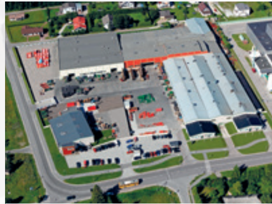
L'usine Fors MW est conçue pour la production de petites séries. Elle se trouve à Saue, à 15 km de Tallinn, Estonie. La zone de production s'étend sur 40 000 m 2 , dont 18 000 m 2 couverts.
