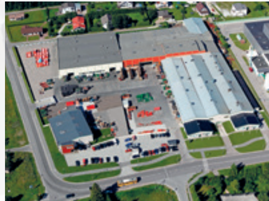
Fors MW ja tehtaamme on suunniteltu erityisesti lyhyitä sarjatuotantoja varten. Tehtaamme sijaitsee Viron Saussa, 15 km päässä Tallinnasta. Tuotantoala on 40 000 m 2 , josta 18 000 m 2 on katettua.
