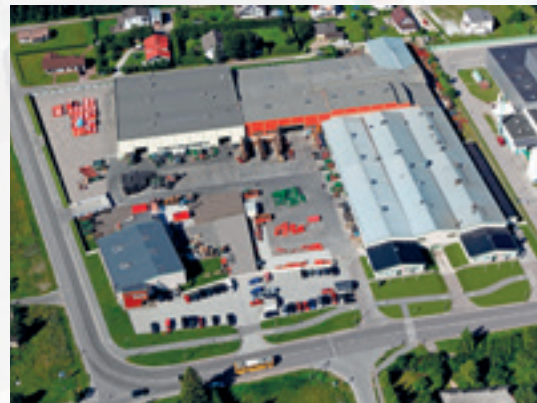
Fors MW tehas on rajatud väikeseerias tootmiseks. See asub Eestis, Tallinnast 15 km kaugusel Sael. Tootmisala suurus on 40 000 m 2 , millest on katusealust pinda 18 000 m 2 .
